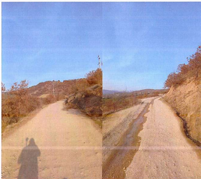
Figura 1 Gjendja ekzistuese e rruges.
