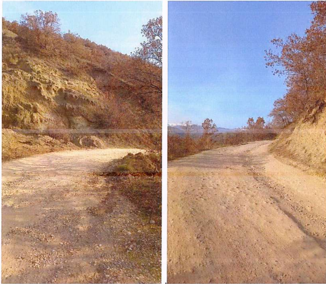
Figura 2 Gjendja ekzistuese e rruges
