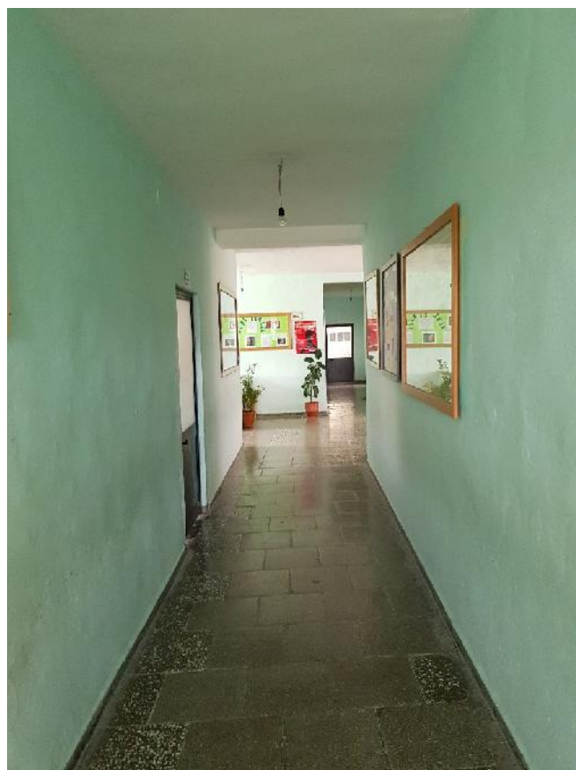
Foto te gjendjes ekzistuese te shkoll
