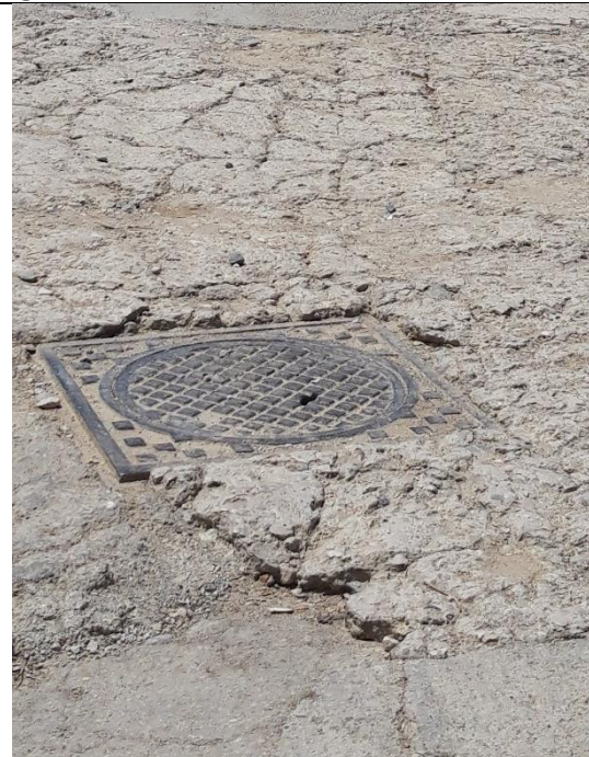
Fig. 1-23 Pikë depresioni në Prog.0+360, për largimin e UB dhe UZ
