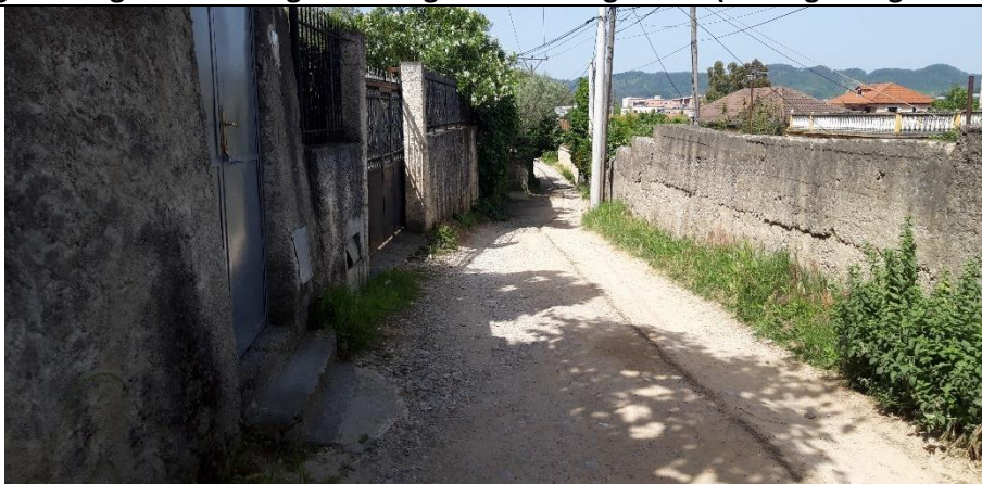
Fig. 1-14 Mungesa e plotë e shtresave asfaltike; mure rrethues prej betoni ose blloqe betoni të banesave përgjatë rrugës
