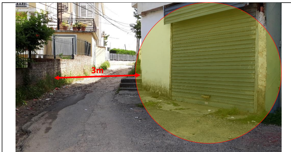
Fig. 1-7 Godinë banimi në Prog.0+148; gjerësia e rrugës 2 ÷ 3m
