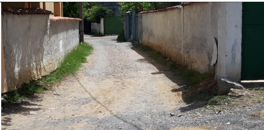
Fig. 1-17 Shtresat asfaltike dhe muret rrethuese të ndërtesave (foto në Prog.0+610)
