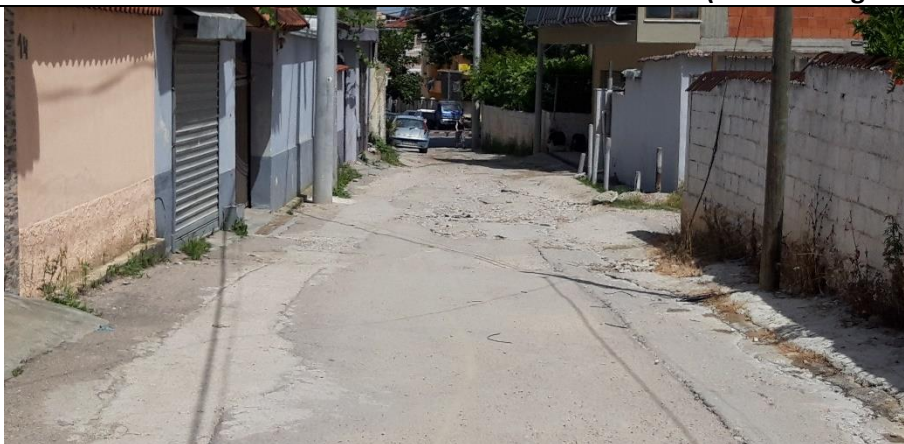
Fig. 1-18 Shtresat asfaltike dhe muret rrethuese të ndërtesave (foto në Prog.0+680)
