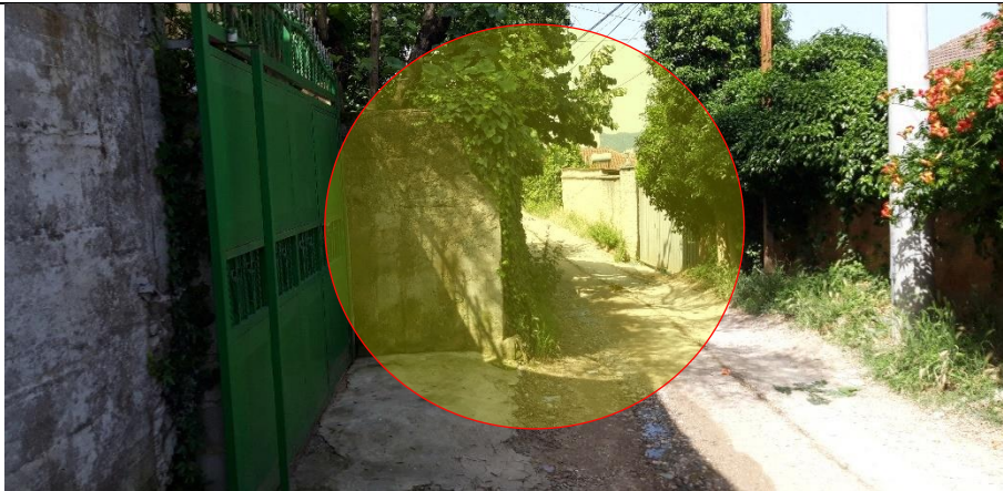
Fig. 1-13 Ngushtimi i rrugës në Prog.0+223 ÷ Prog.0+240 (foto nga Prog.0+240)
