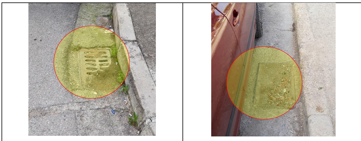
Fig. 1-21 Puseta UB të cilat janë të bllokuara dhe janë jashtë funksionit
