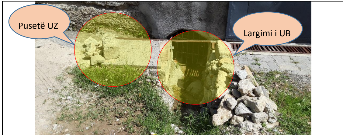
Fig. 1-23 Pikë depresioni në Prog.0+360, për largimin e UB dhe UZ
