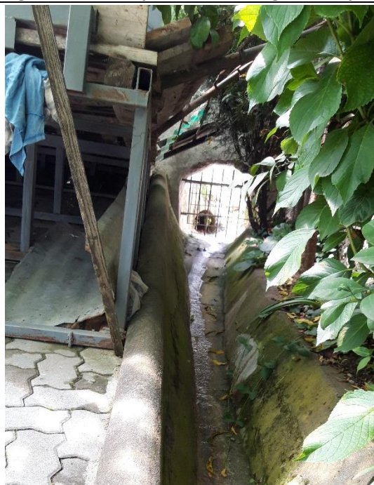
Fig. 1-23 Pikë depresioni në Prog.0+360, për largimin e UB dhe UZ
