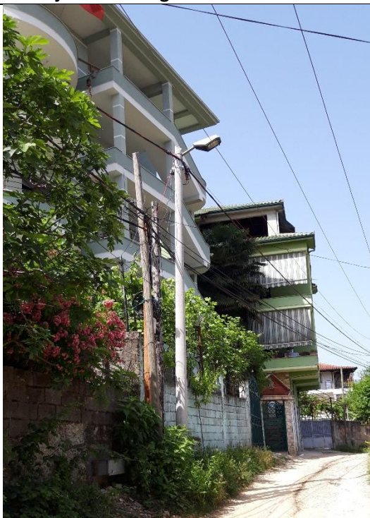
Fig. 1-16 Ndërtesa 5-kat dhe 4-kat, Prog.0+455 dhe Prog.0+400, krahu i djathtë
