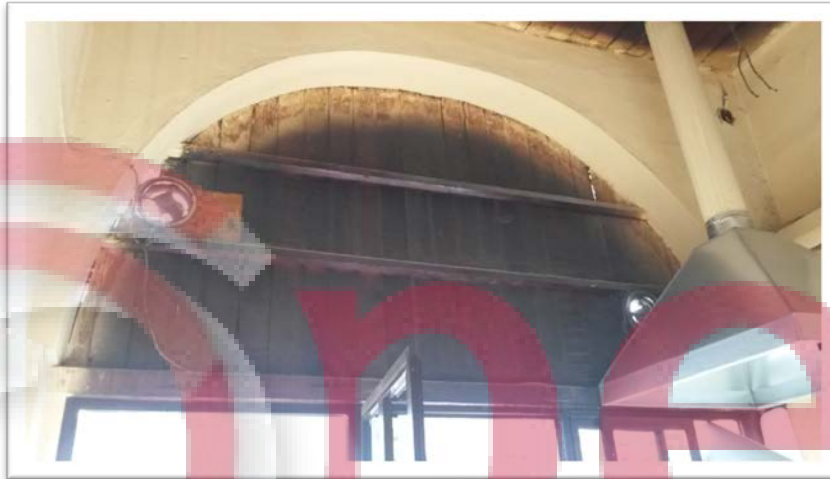
Fig. 19 – Mënyra e montimit të elementëve të drurit në pjesën e harqeve
