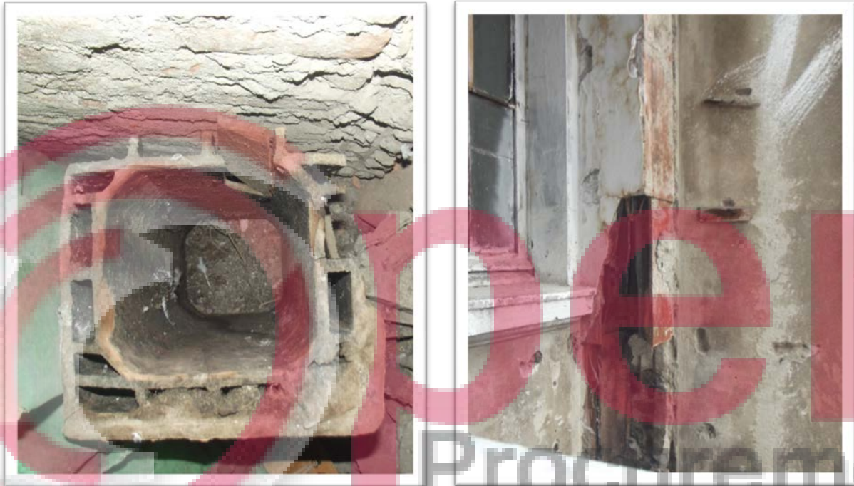
Fig. 16 – Majtas – element i ndërtimit të tubave vertikale të ajrimit të tymrave të podrumit; djathtas – mënyra e vendosjes së tyre në objekt.
