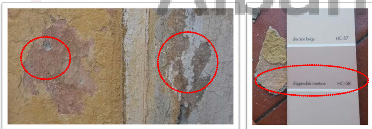
Fig. 11 – Sondazh për evidentimin e ngjyrës origjinale të lyerjes së fasadës. Majtas sipërfaqja e muraturës dhe dekorit. Djathtas, krahasimi i një kampioni të marrë në objekt dhe përcaktimi i kodit të ngjyrës për lyerjen.
