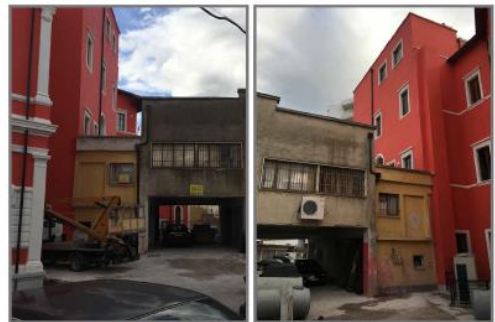
FOTO TE GJENDJES EKZISTUESE
