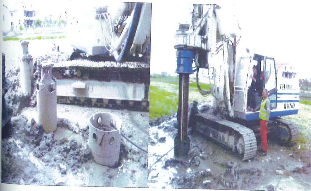
foto II.1. Sonda e kryerjes së shpimit dhe instrumenti shpues
