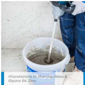
Përgatitja e produktit Planitop Rasa & Ripara R4 Zero
