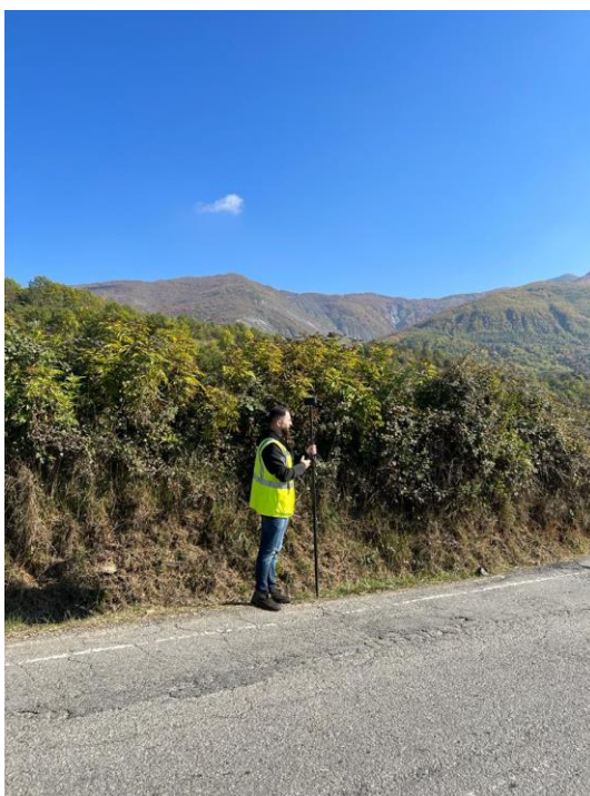
Figura 3: Gjendja ekzistuese e rruges
