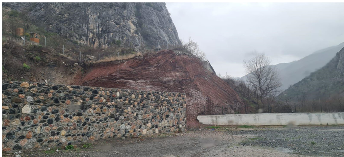
Foto 4. Aluvionet e shtratit, zhavorre, rëra, alevrolite të Hollocenit, djathstas, ku po bëhet zgjerim rruge.
