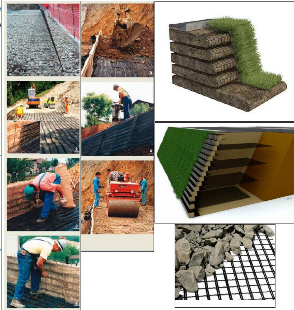
Figura 5-22 Foto të procedurës së aplikimit të Geogridit të përdorur
