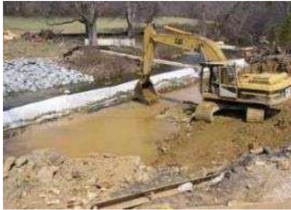
Figura 9-2 Përdorimi i silt fence pranë burimeve ujore
