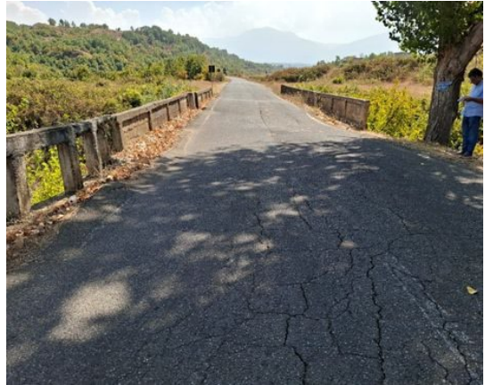
Foto A3.2 – Segment mbi mur mbajtës me parapet të amortizuar
