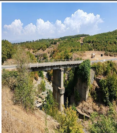
Foto A3.9 – Urë ekzistuese me pila dhe trarë b/a
