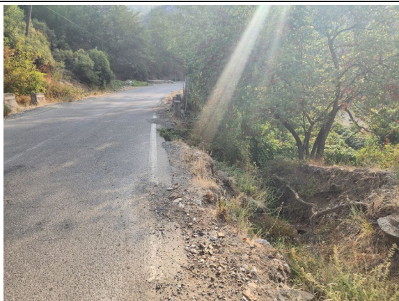
Foto A3.7 – Cedim i bankinës dhe i skajit të karrexhatës
