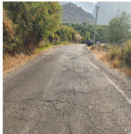
Foto A3.4 – Humbje e shtresës përfundimtare, sipërfaqe me granulometri të trashë
