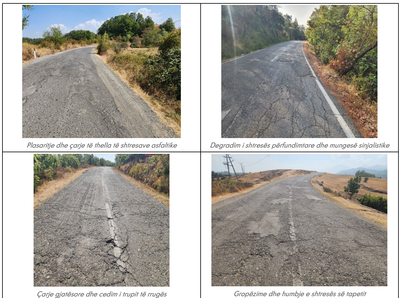
Figura 3. Gjendja e shtresave rrugore (verifikim paraprak në terren, 2026).
