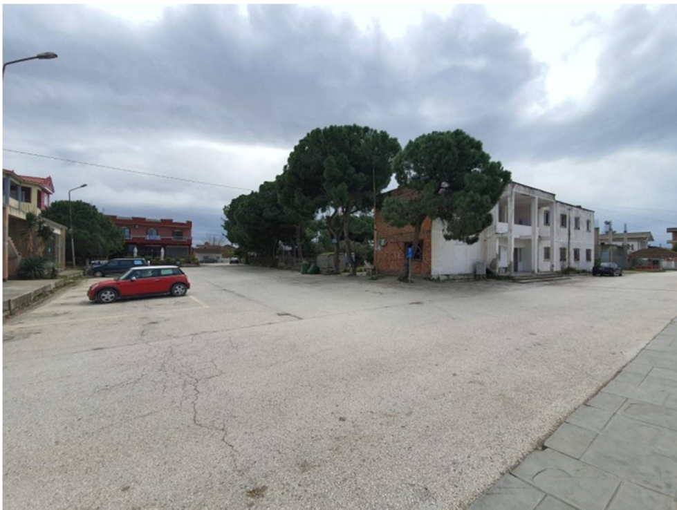
Foto te gjendjes egzistuese VERIU (fasada nga sheshi qendror)
