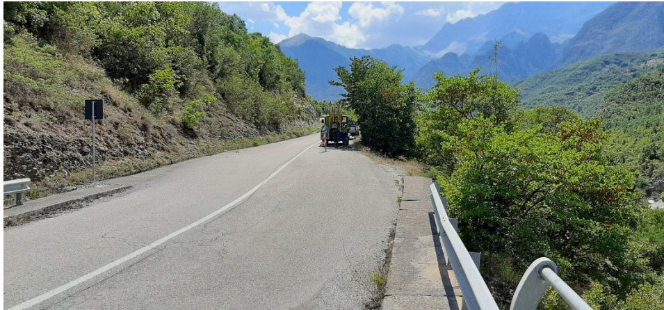
Foto nr.33 Pozicioni i sondes ne BH-17
