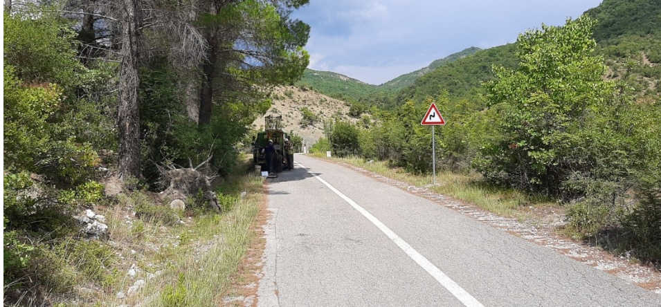
Foto nr.39 Pozicioni i sondes ne BH-20
