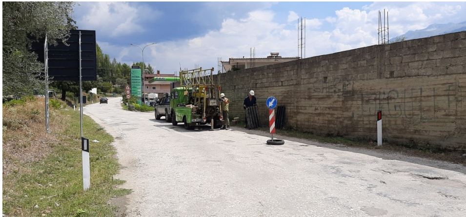
Foto nr.1 Pozicioni i sondes ne BH-1
