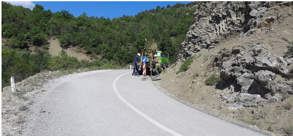
Foto nr.43 Pozicioni i sondes ne BH-22
