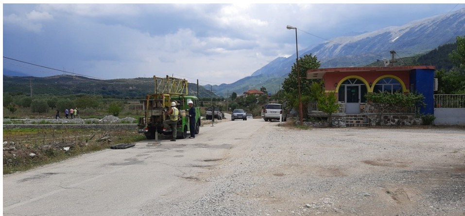
Foto nr.3 Pozicioni i sondes ne BH-2
