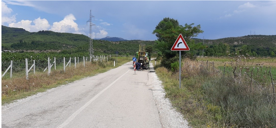
Foto nr.5 Pozicioni i sondes ne BH-3
