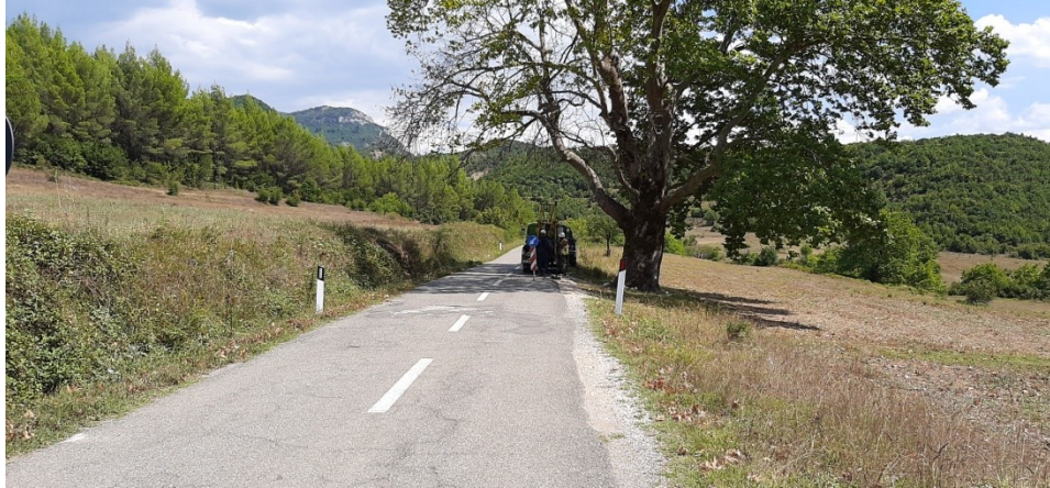
Foto nr.37 Pozicioni i sondes ne BH-19
