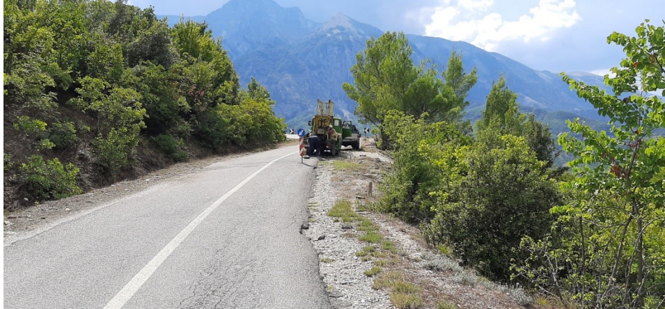
Foto nr.41 Pozicioni i sondes ne BH-21
