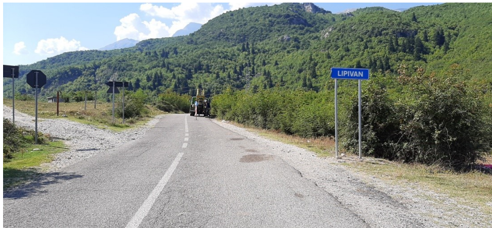
Foto nr.17 Pozicioni i sondes ne BH-9
