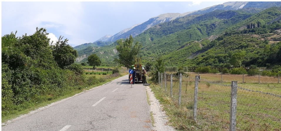
Foto nr.9 Pozicioni i sondes ne BH-5
