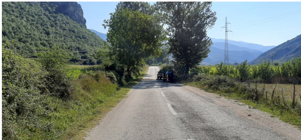
Foto nr.13 Pozicioni i sondes ne BH-7
