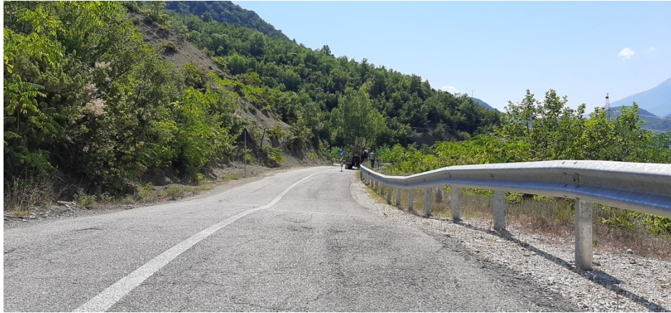
Foto nr.21 Pozicioni i sondes ne BH-11
