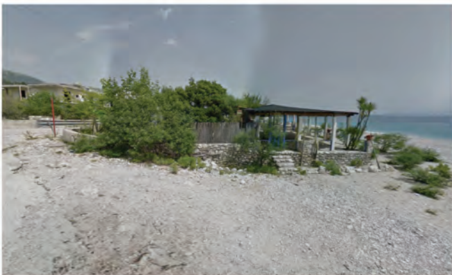
Pavilion buzë detit me strukturë druri, bazament guri dhe bimësi të pakontrolluar
