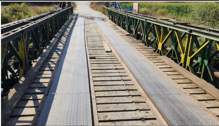
Figura 2-39: Foto të gjëndjes ekzistuese të platformës së mbistrukturës
