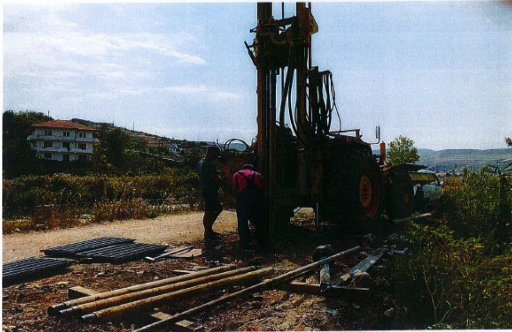
Fig nr. 22 Proçesi gjatë shpimit sonda në BH nr. 5
