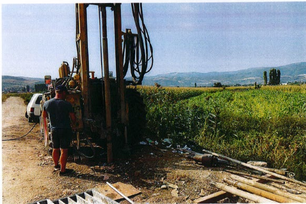
Fig nr. 23 Proçesi gjatë shpimit sonda në BH nr. 6
