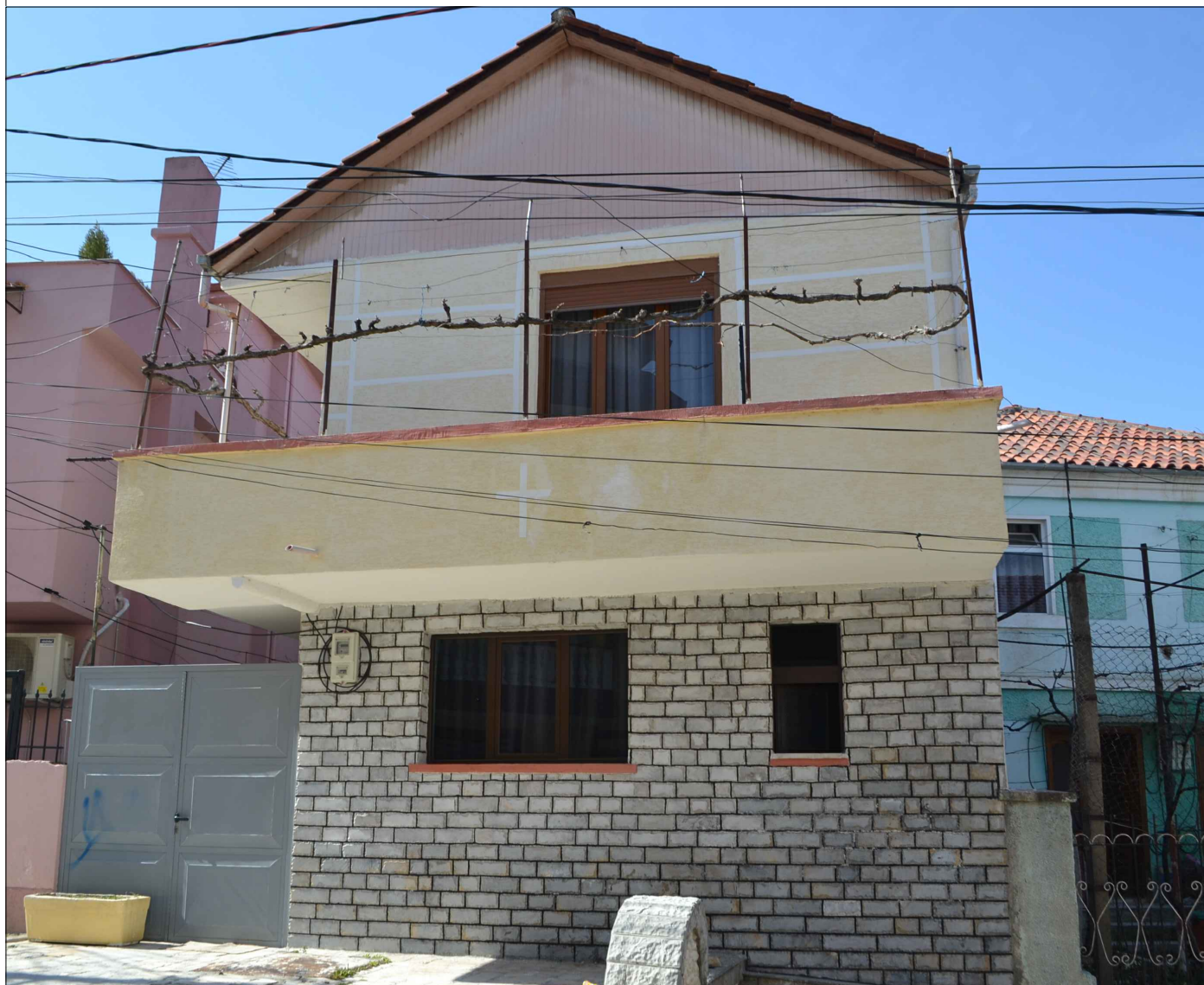
FOTO TË GJENDJES EKZISTUESE
