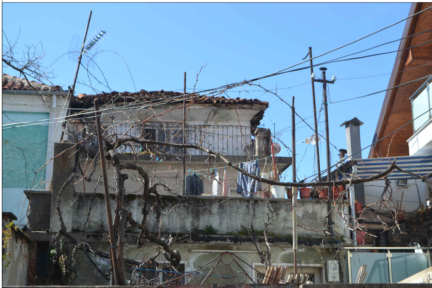
FOTO TË GJENDJES EKZISTUESE
