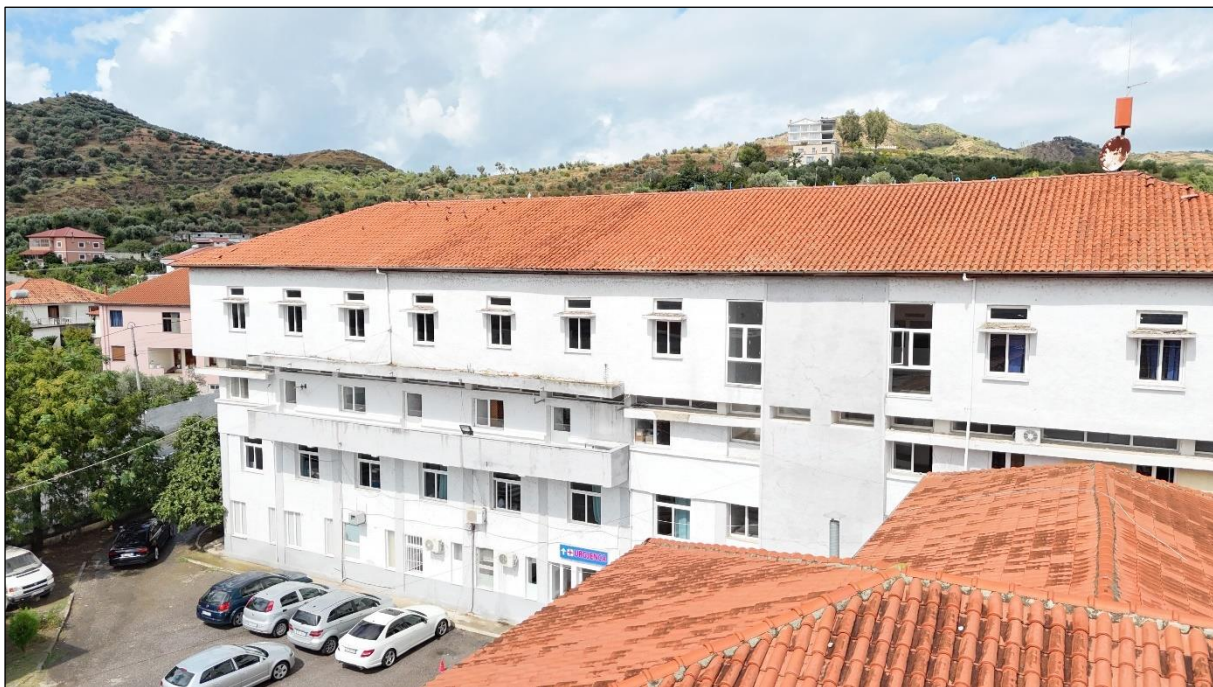
Figura 2-5: Foto e Gjendjes Ekzistuese e Objektivit 1 (4 kt) që propozohet të Transformohet në Qendër Terapeutike Dhe Rehabilituese Për Fëmijët, Peqin
