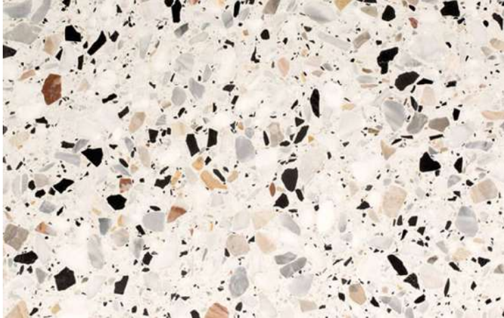
Fig 30 – Detaji shtresa betoni e rrashinuar, korsa e bicikletave , Bulavardi i Jacarandave.
