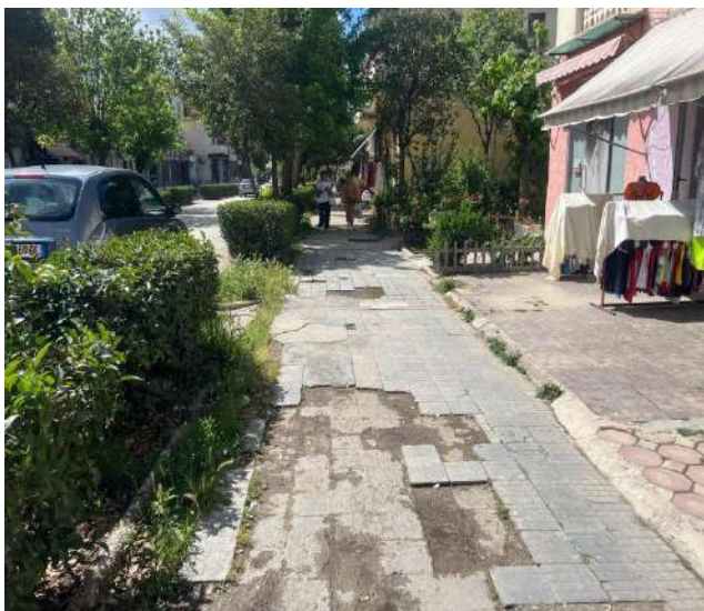
Figure 15 -trotuare te demtuara
