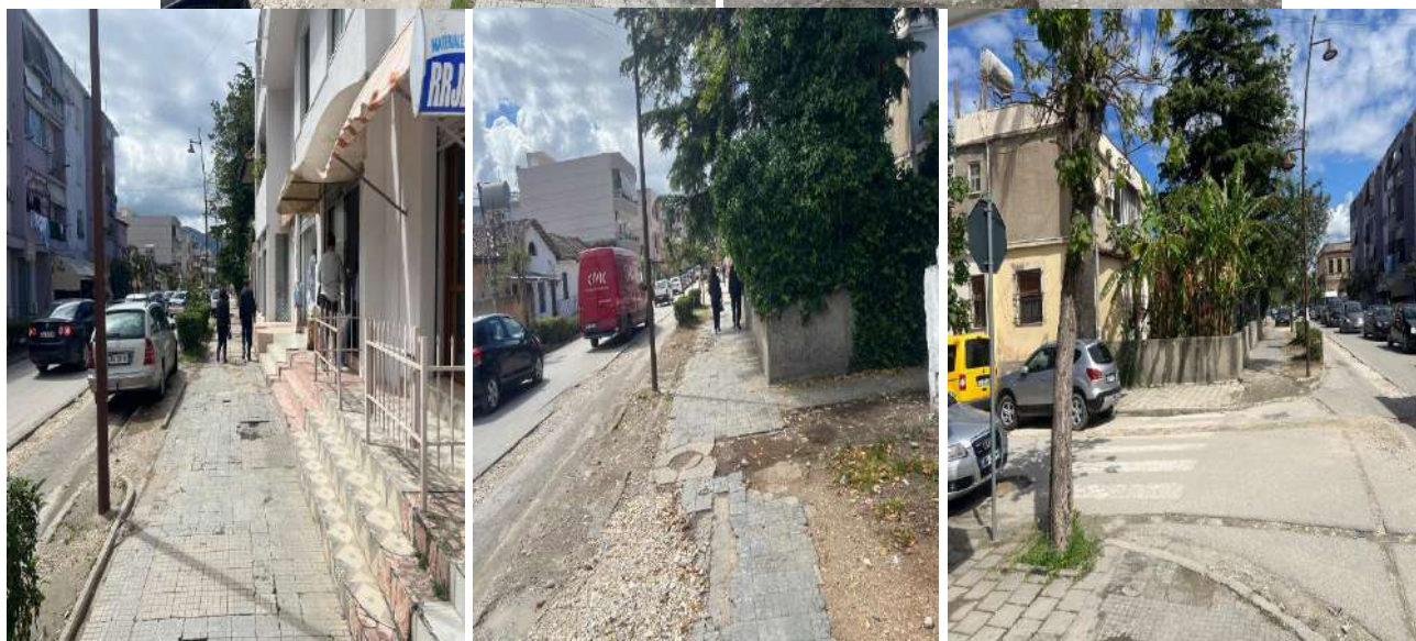
Figure 11 -dëmtim trotuaret dhe shtresat e rruges nga carjet
