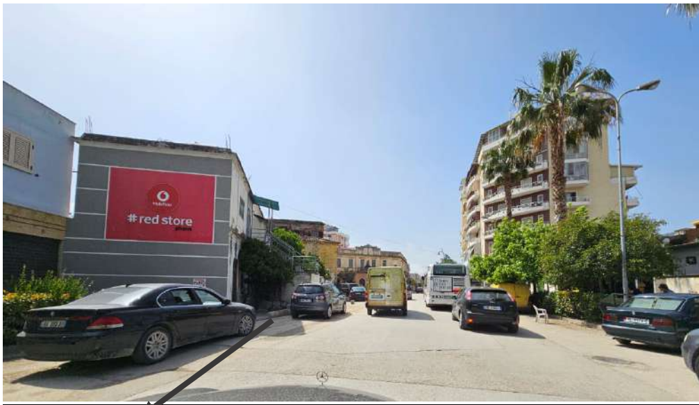
Figure 2 Nderhyrjet e realizuara ne rikonstrukcion te rrjetin ekzistues te ujesjellesit
