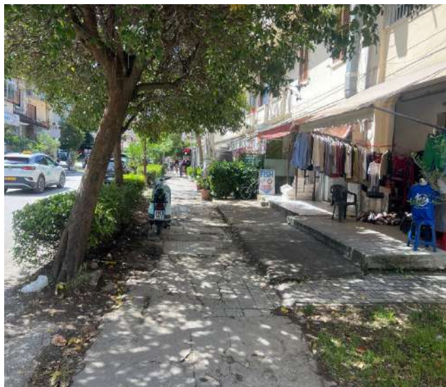
Figure 15 -trotuare te demtuara
