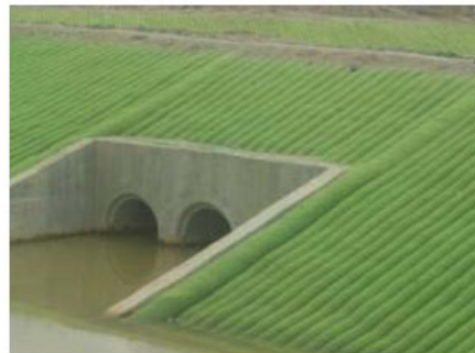
Figura 10: Pamje te dyshekut te mbushur me rere ne argjinatura
