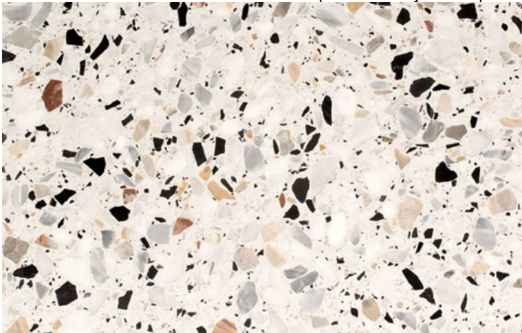
Fig 32 – Detaji shtresa betoni e rrashinuar, korsa e bicikletave , Bulavardi i Jacarandave.
