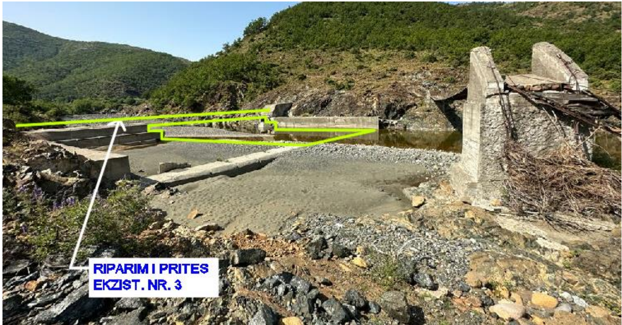
Fig.21 Pamje e aksit te lumit, per riparimin dhe mbilartesimin e propozuar ne priten ekzistuese Nr.3.
