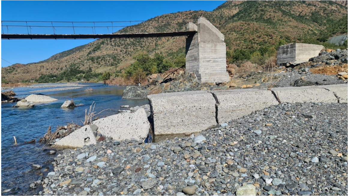
Fotot 8 Pritë ekzistuese Nr.3 (e shkatërruar nga mbulimi me prurje të ngurta)
