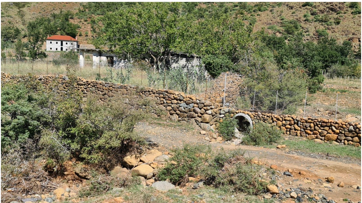
Fotot 5 Murë guri në të thatë për mbrojtjen e banesave dhe të tokave.
