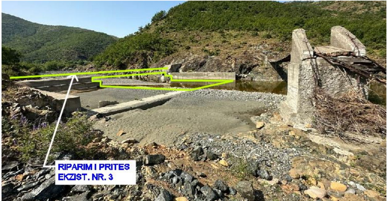
Fig.6 Pamje e aksit te lumit, per riparimin dhe mbilartesimin e propozuar ne priten ekzistuese Nr.3.
