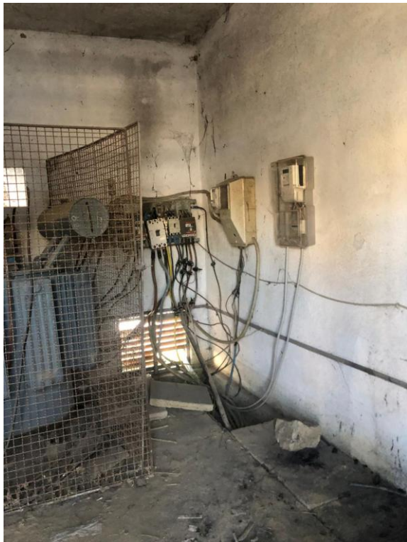
Gjendja e automateve dhe e kabines ne kabinen PSH 10 F28 Nst kashar
