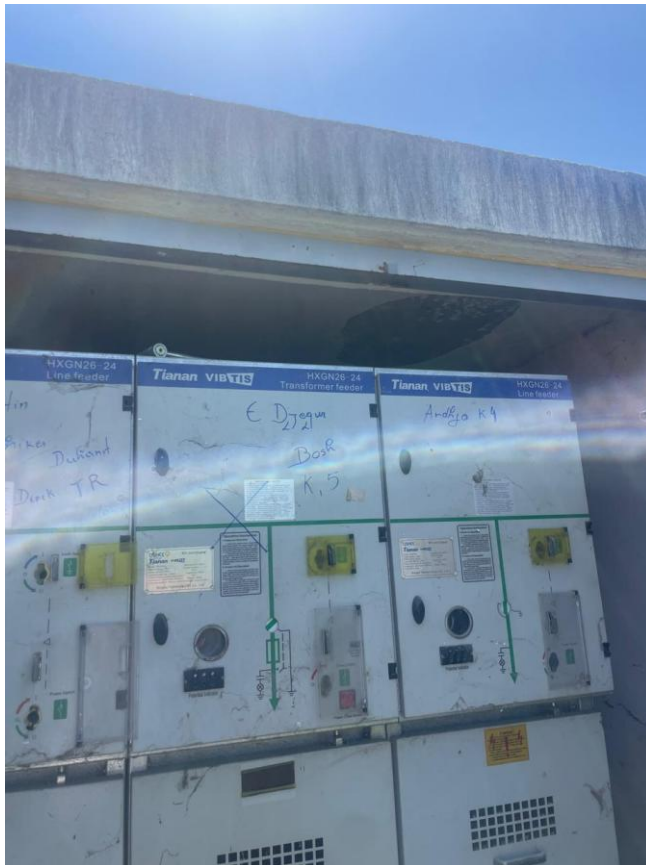
Kabina K3 T2 Celat e demtuara N/ST kombinat
