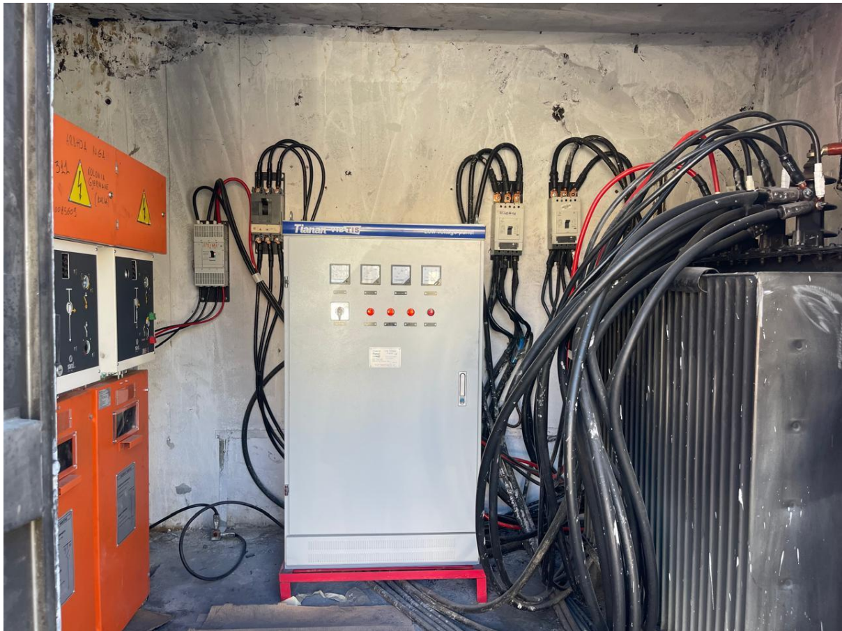
Kabina Kengetarja NST Traktora Transformatori pa rrethim, Kabllot e pasistemuara
