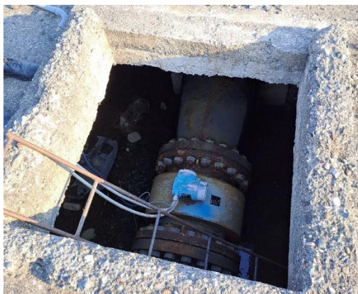
Figura 5: Tubi i dërgimit DN700 me matësin.
