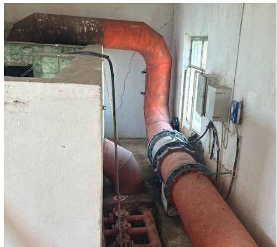
Figura 14: Matja e prurjes në tubin që furnizon depon Arapaj
