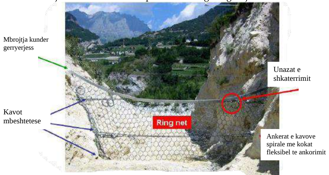
Komponentet e një barriere fleksibël
