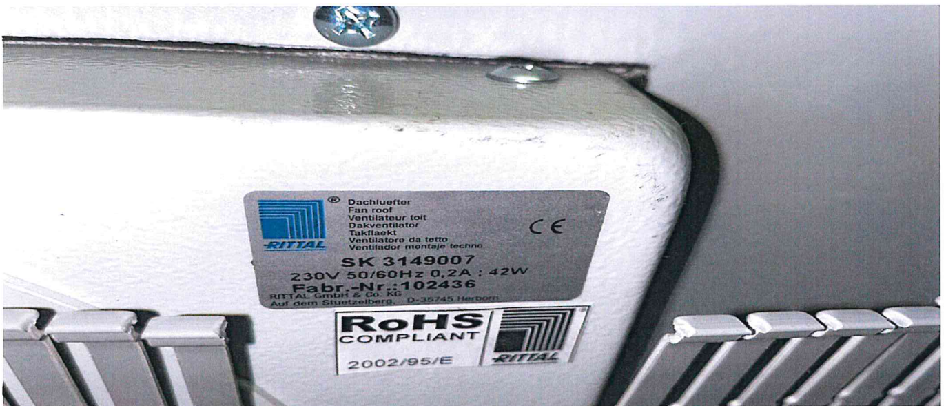
Foto nga afer e targetit te ventilatorit ekzistues Model SK 3149.007
