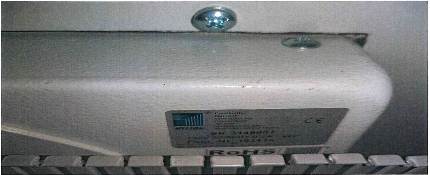
Foto te ventilatorit ekzistues Model SK 3149.007 ne vend-montimin e tij brenda Panelit te Kontrollit
