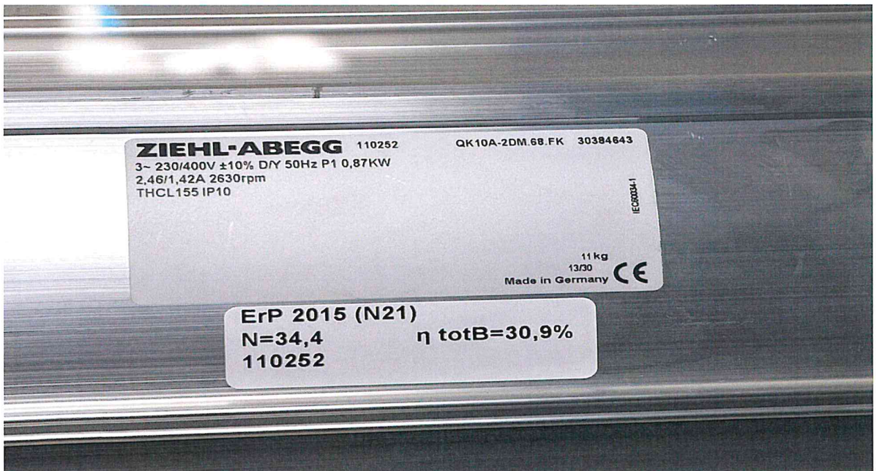
Foto e Ventilatorit brenda Panelit te Eksitimit te agregatit
