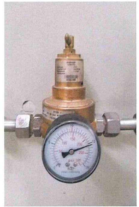
PAMJE TE REDUKTORIT PRESIONIT NE VEND-MONTIM (TEK PANELI I FRENIMIT)
