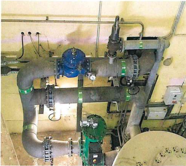
Foto te Rregullatorit te Presionit te ujit ne vend-montimin perkates ne Sistemin e Ujit Ftohes te Agregatit
