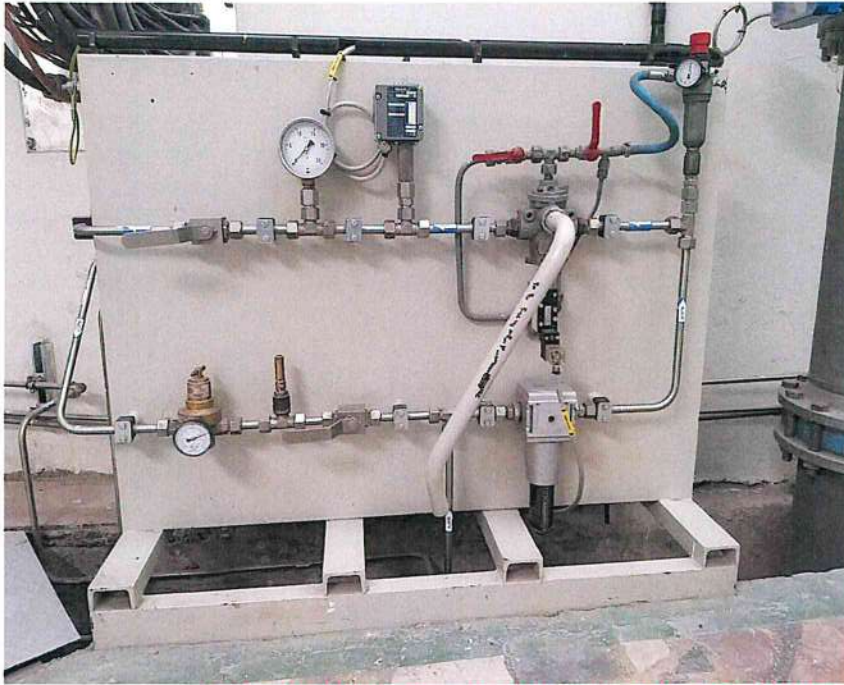
PAMJE TE REDUKTORIT PRESIONIT NE VEND-MONTIM (TEK PANELI I FRENIMIT)
