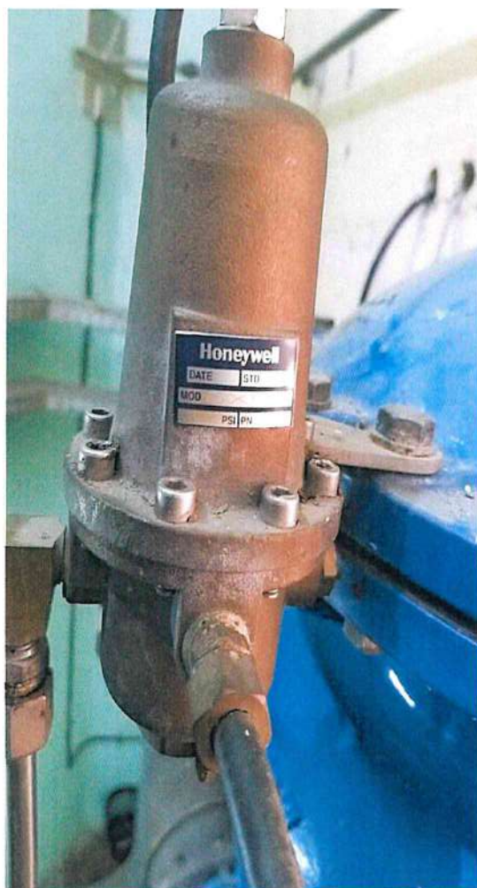
Foto e targetit te paisjes se Valvules Pilotuese Model CX-PR ne vend-montimin e saj.
