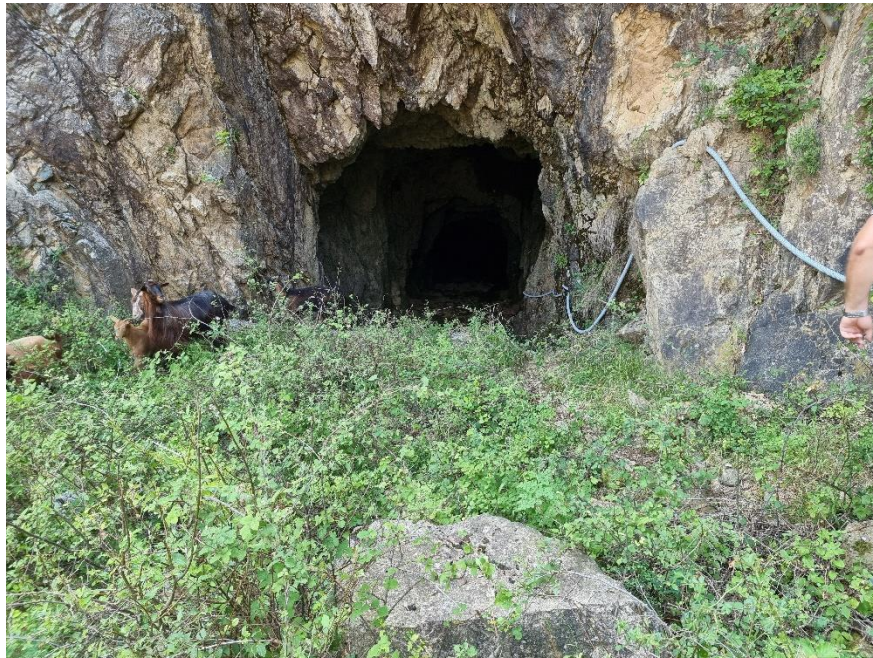
Figure I-1- Gjendja ekzistuese e hyrjes së Galerise.
