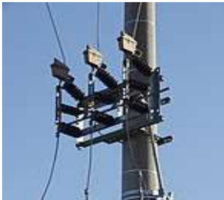
Foto ilustruese ndares 35kV montim pozicioni vertikal
