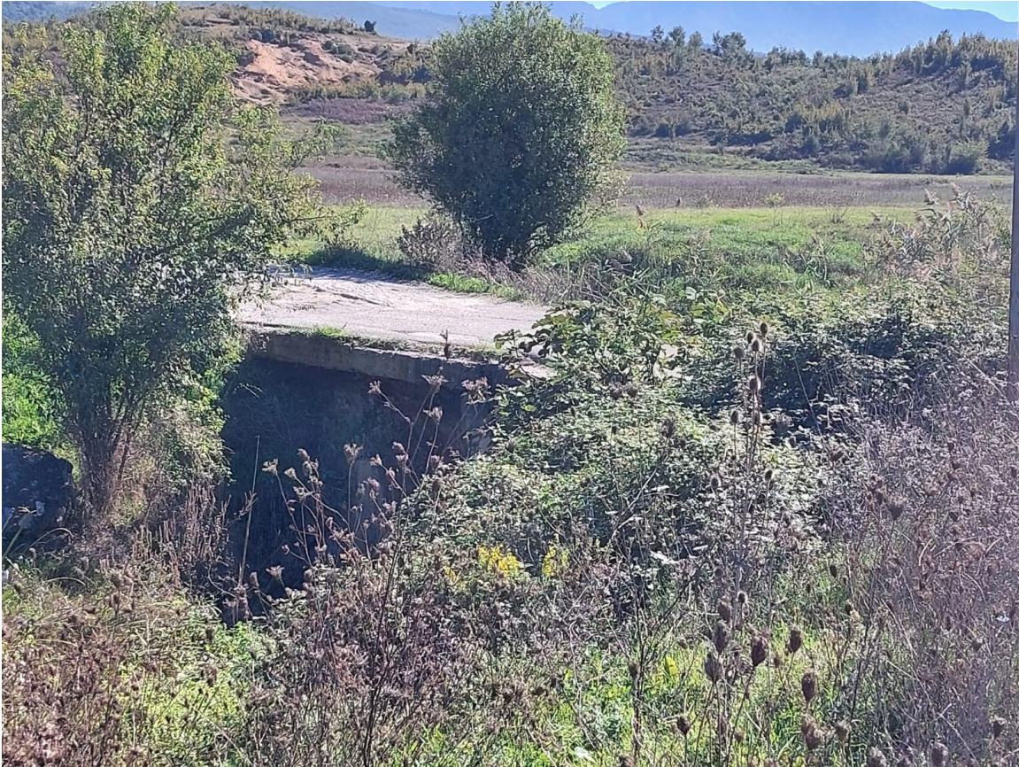
Foto. Segmenti 2, rruga Borizanë-Superstrada Fushë Krujë-Milot (Ura mbi kanalën KK1)
