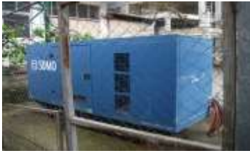
Motogjeneratori tip SDMO, me motor John Deere model 6068HF120, 144 kW, i Stacionit te Pompimit te Ujrave te Ndotura
