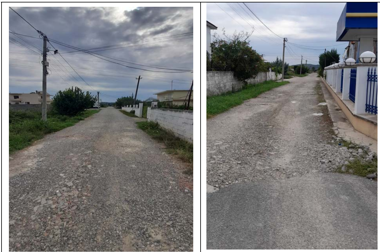
Foto te gjendjes ekzistuese te rruges se fshatit Malasenj
