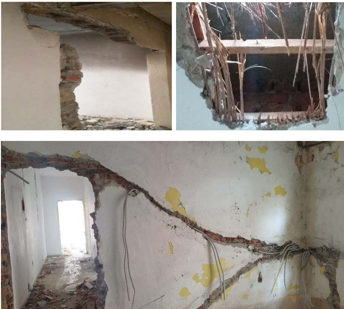
Fig. 5: Foto te gjendjes egzistuese
