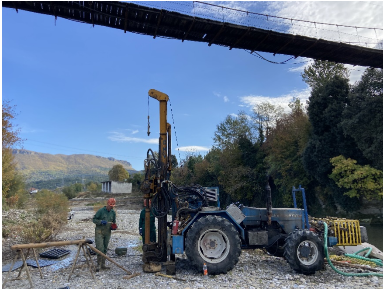
Foto nr.1 Pozicioni i sondes gjate kryerjes se shpimit BH-1
