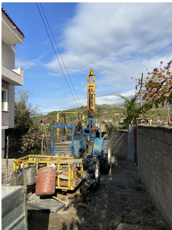
Foto nr.6 Pozicioni i sondes gjate kryerjes se shpimit BH-2
