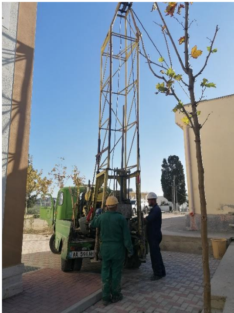
Foto nr.1 Pamje nga mobilizimi i sondes per kryerjen e shpimit BH-1
