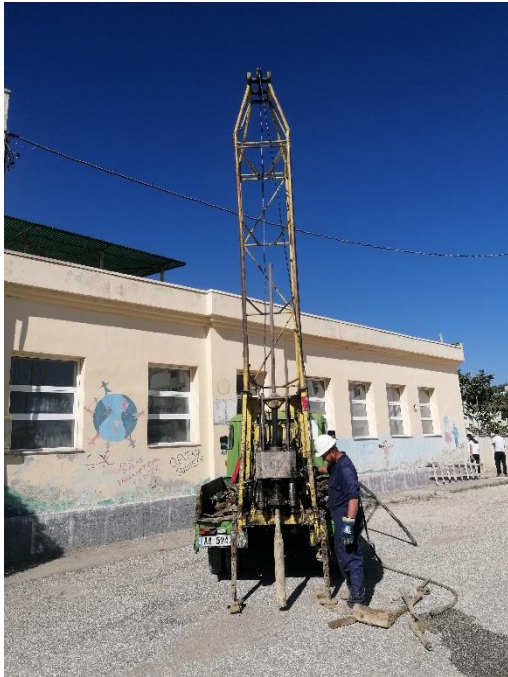
Foto nr.5 Pamje nga mobilizimi i sondes per kryerjen e shpimit BH-2
