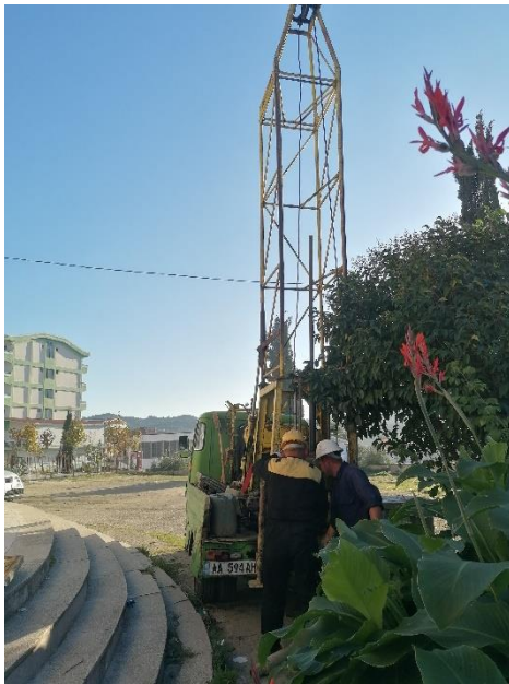
Foto nr.9 Pamje nga mobilizimi i sondes per kryerjen e shpimit BH-3
