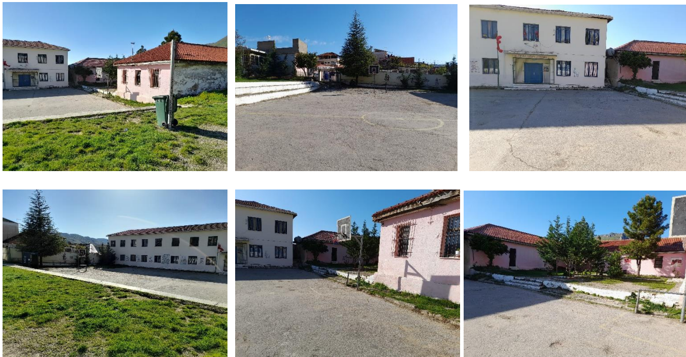
FOTO 2 Foto te gjendjes ekzistuese
