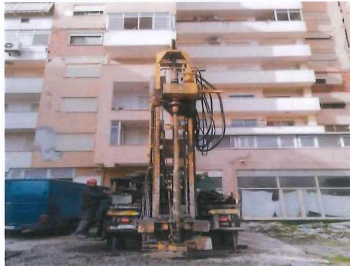
Foto nr.1 Pozicioni i sondes ne BH-1
