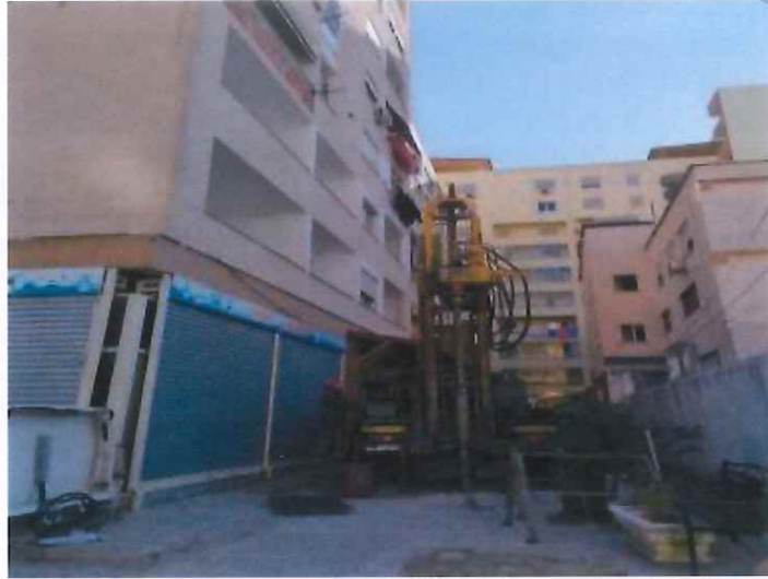
Foto nr.11 Pozicioni i sondes ne BH-3
