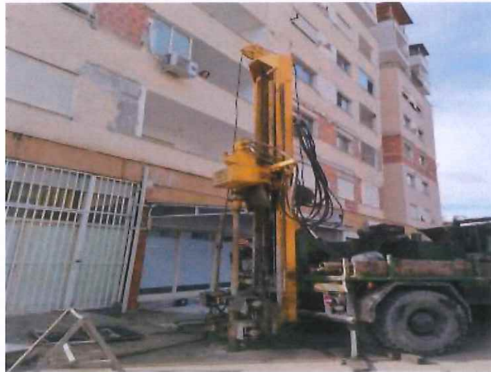
Foto nr 6 Pozicioni i sondes ne BH-2
