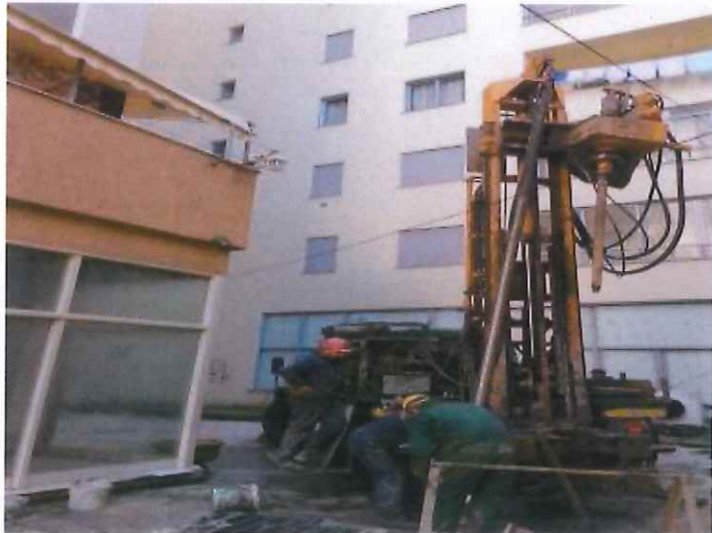
Foto nr.16 Pozicioni i sondes ne BH-4
