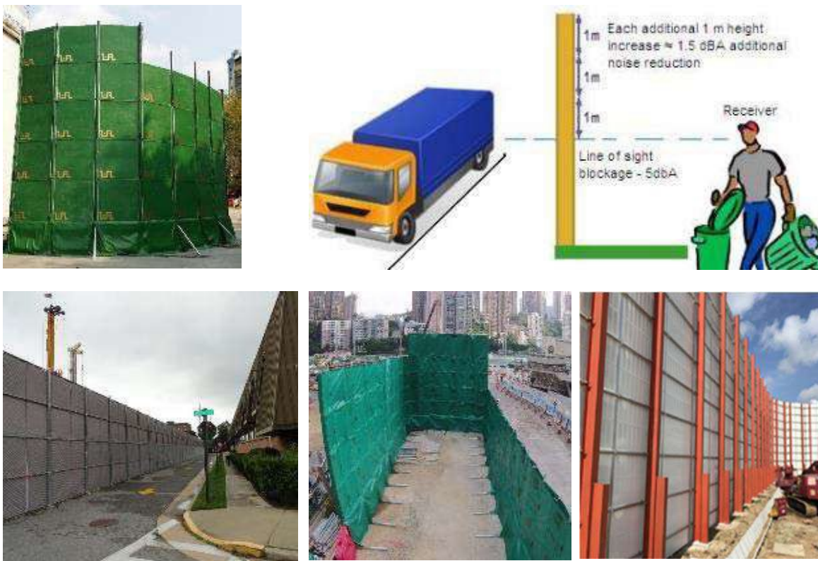
Figurë 70: barriera të përkohshme mbrojtëse ndaj zhurmave të sygjera për reduktimin e nivelit të zhurmave
