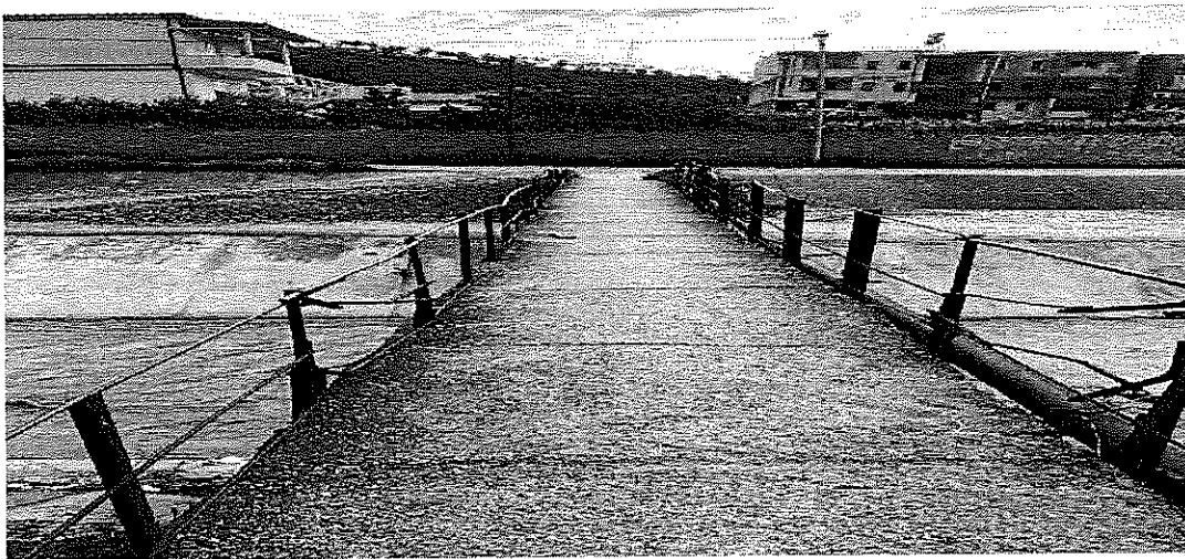
Foto te gjendjes ekzistuese
