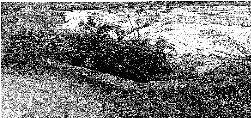
Foto te gjendjes ekzistuese
