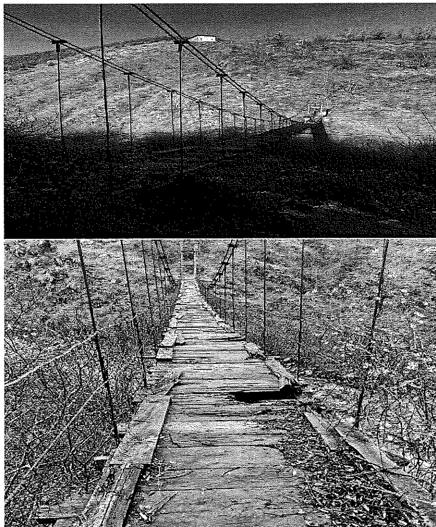
Foto te gjendjes ekzistuese
