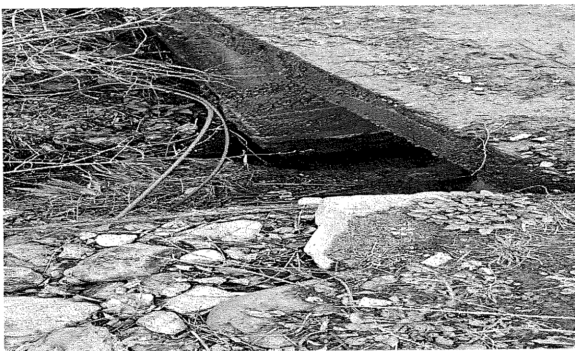
Foto te gjendjes ekzistuese
