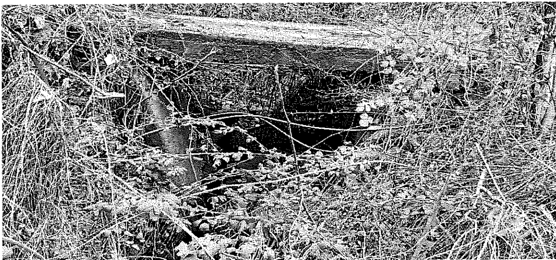
Foto te gjendjes ekzistuese
