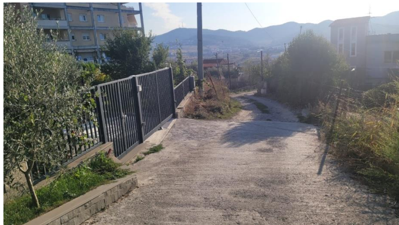
Foto te rrugës ekzistuese per bllokun ne rrugen Ramazan Begu.
