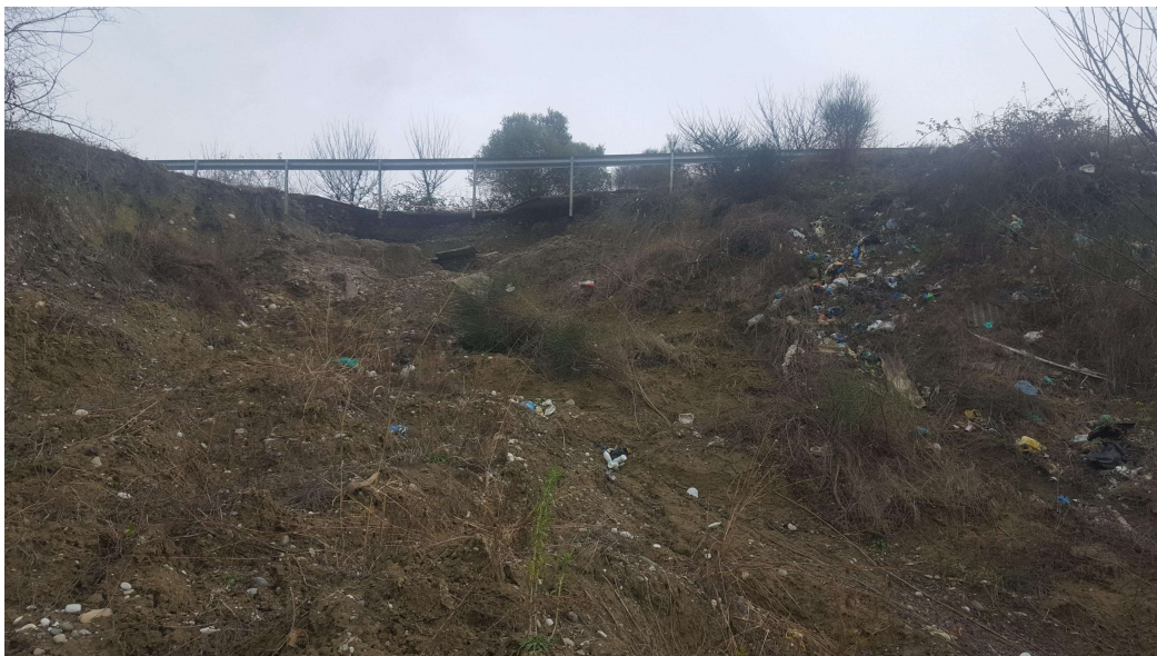
Foto 5&6 Pamje e shkarjes se dherave ne formen e baltes rrjedhese nga trupi i rruges ne drejtim te lugines se lumit Shkumbin
