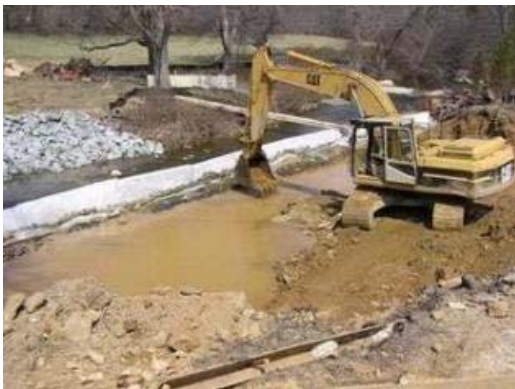
Figure.-11 Përdorimi i silt fence pranë burimeve ujore
