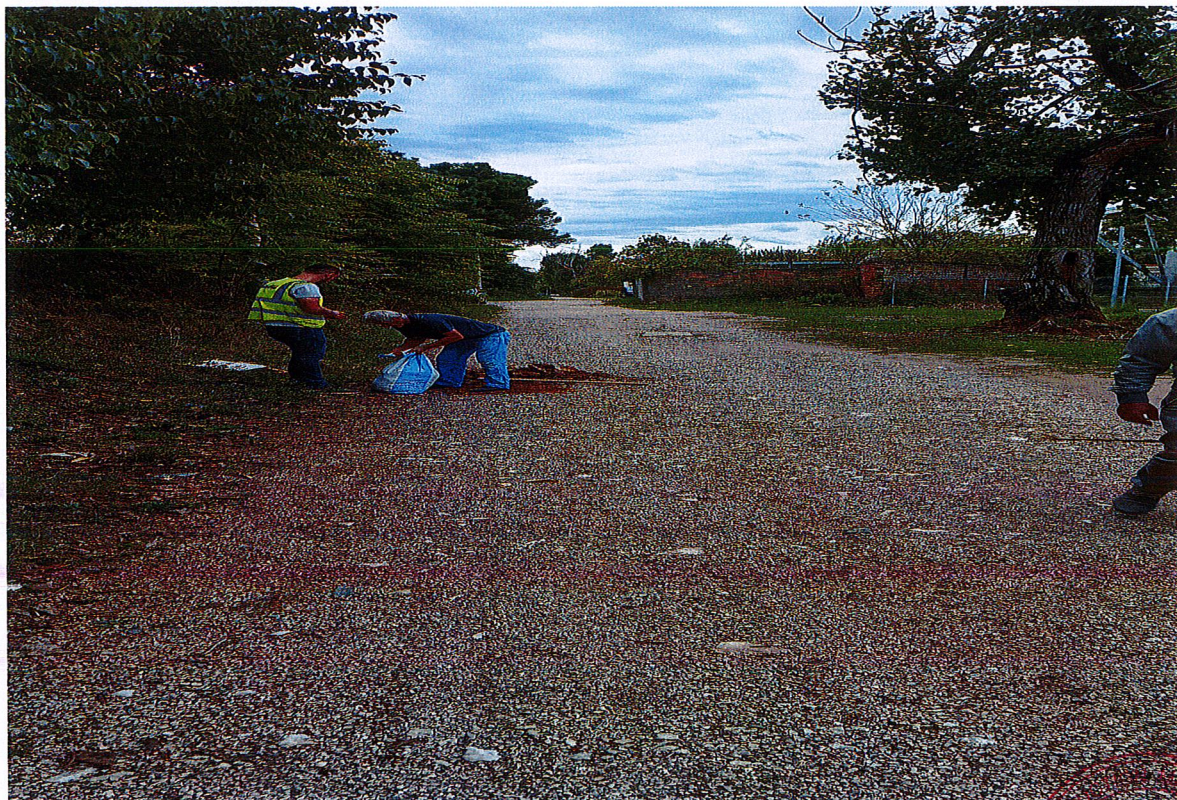
Foto 3. Test pit nr.3, Rruga Demir Liçi
