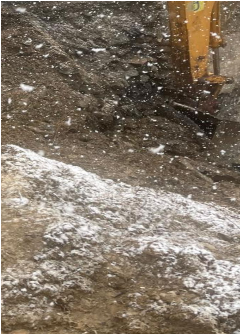
Figura 8 Punimet e kryera ne terren
