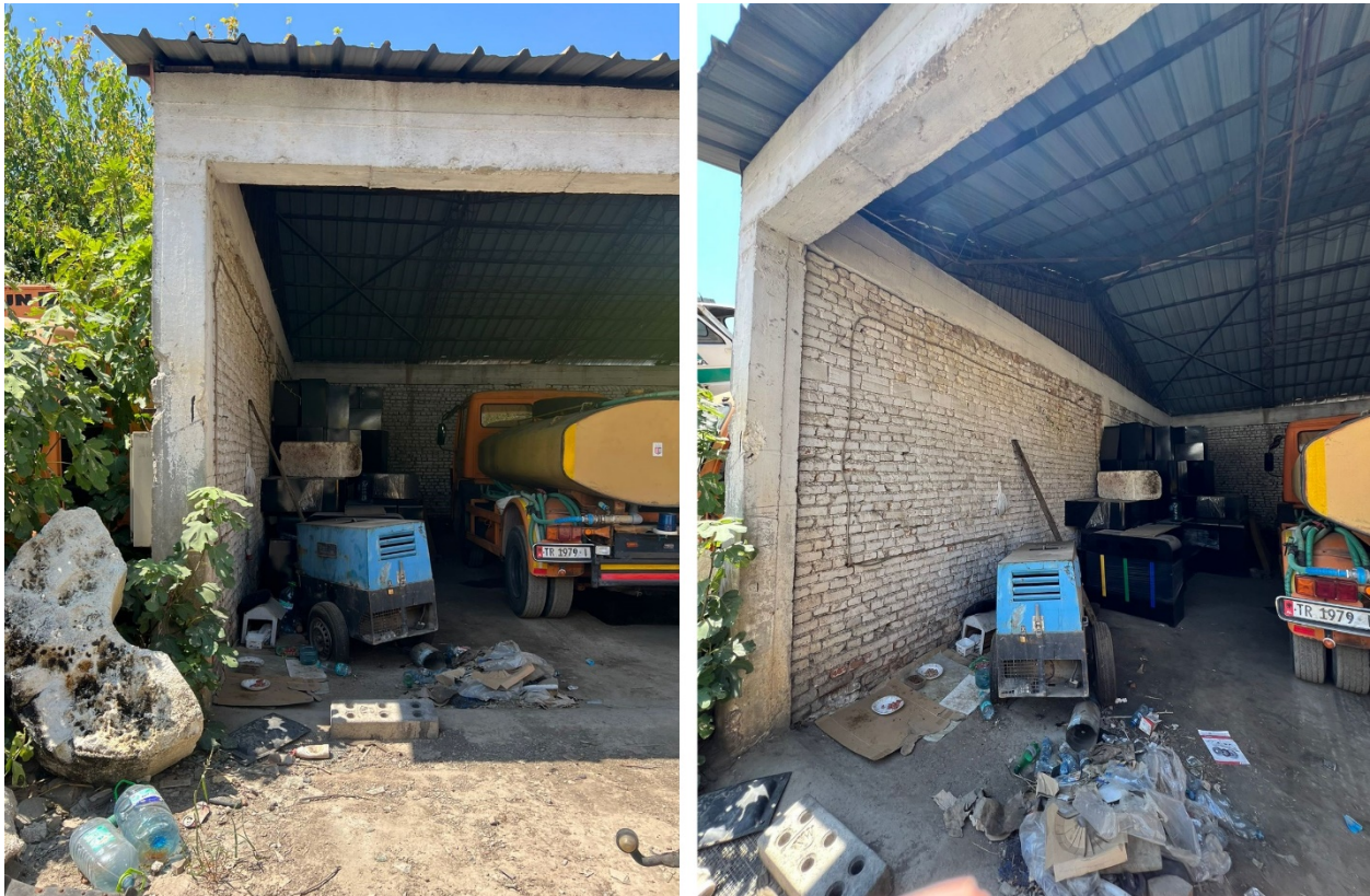
Foto te gjendjes ekzistuese
