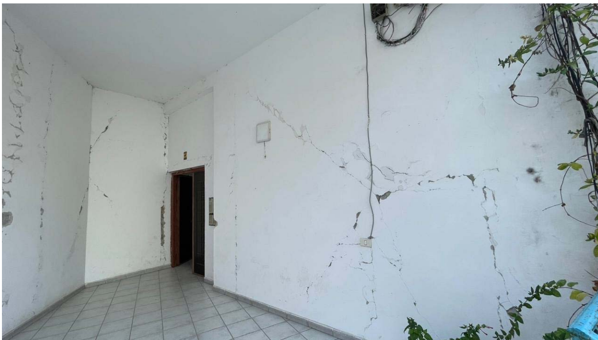
Foto 11. Demtime te mureve ne hyrje te objektit.
