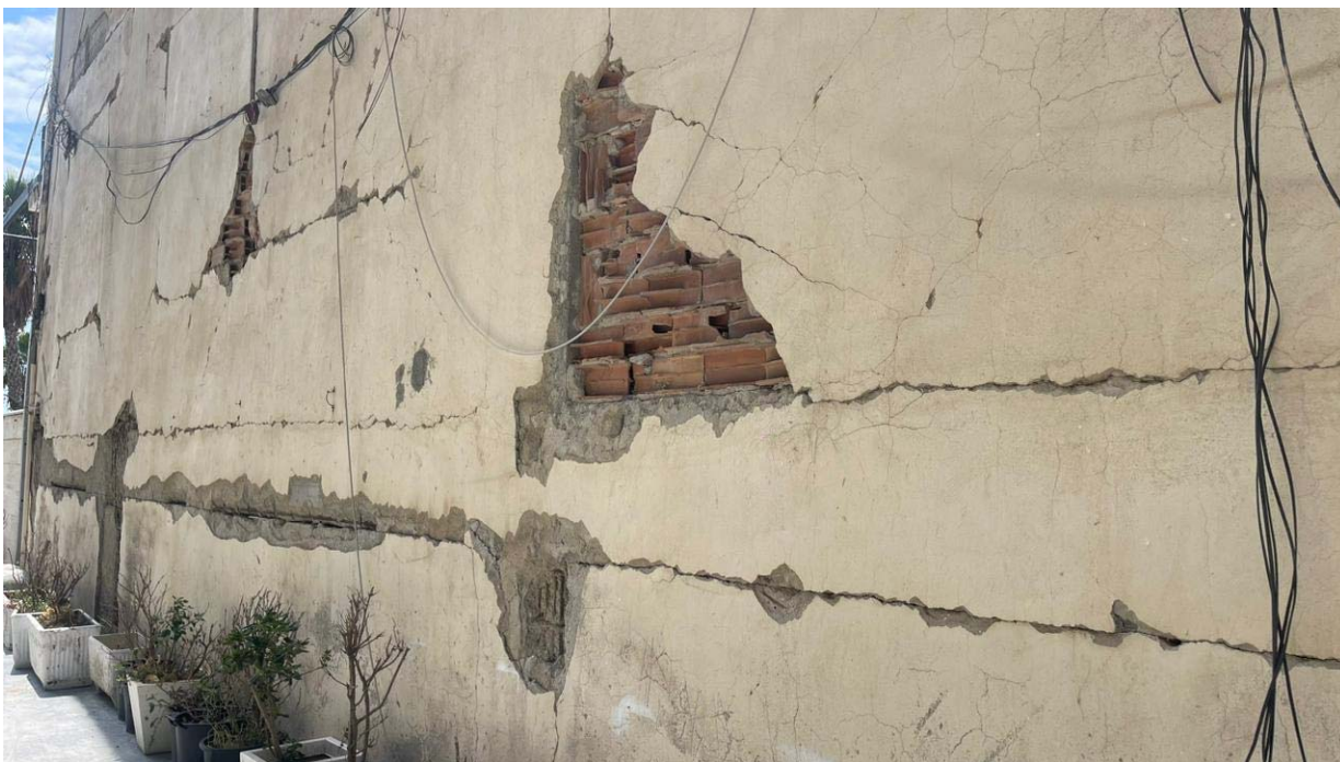
Foto 19. Demtime te muratures dhe kolonave ne katin perdhe te objektit.
