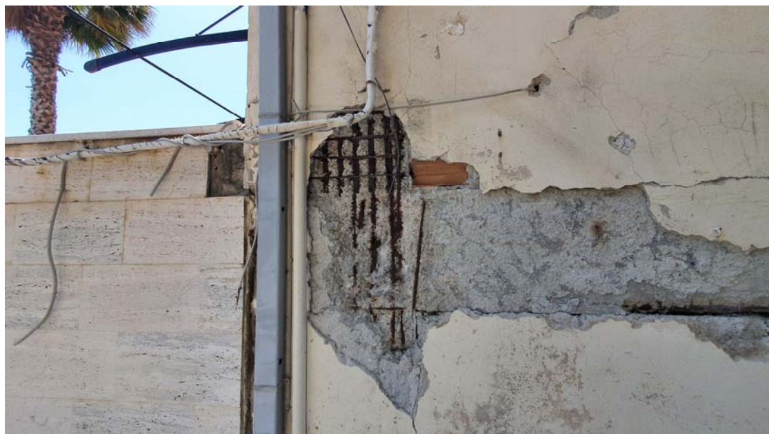
Foto 4. Demtime te kolones ne katin perdhe te objektit.
